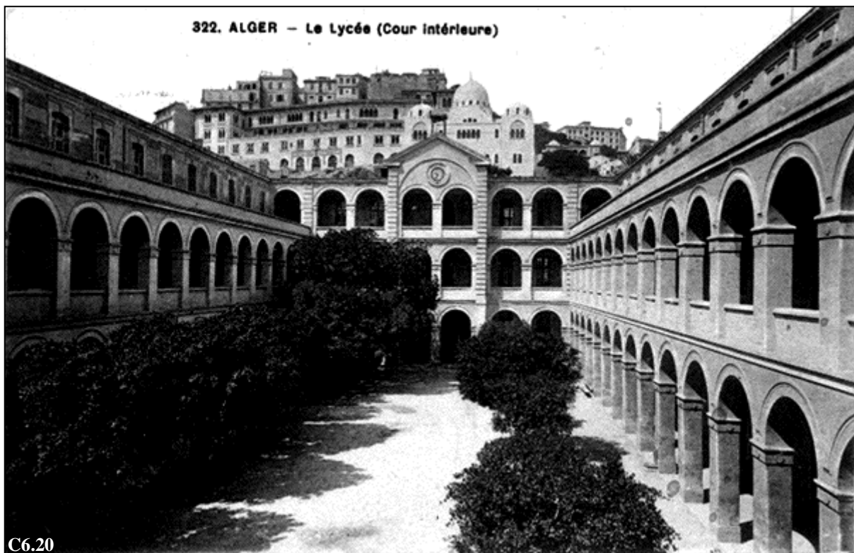
Cour centrale du Lycée Au fond surplombant l'horloge, la Médersa et son dôme
